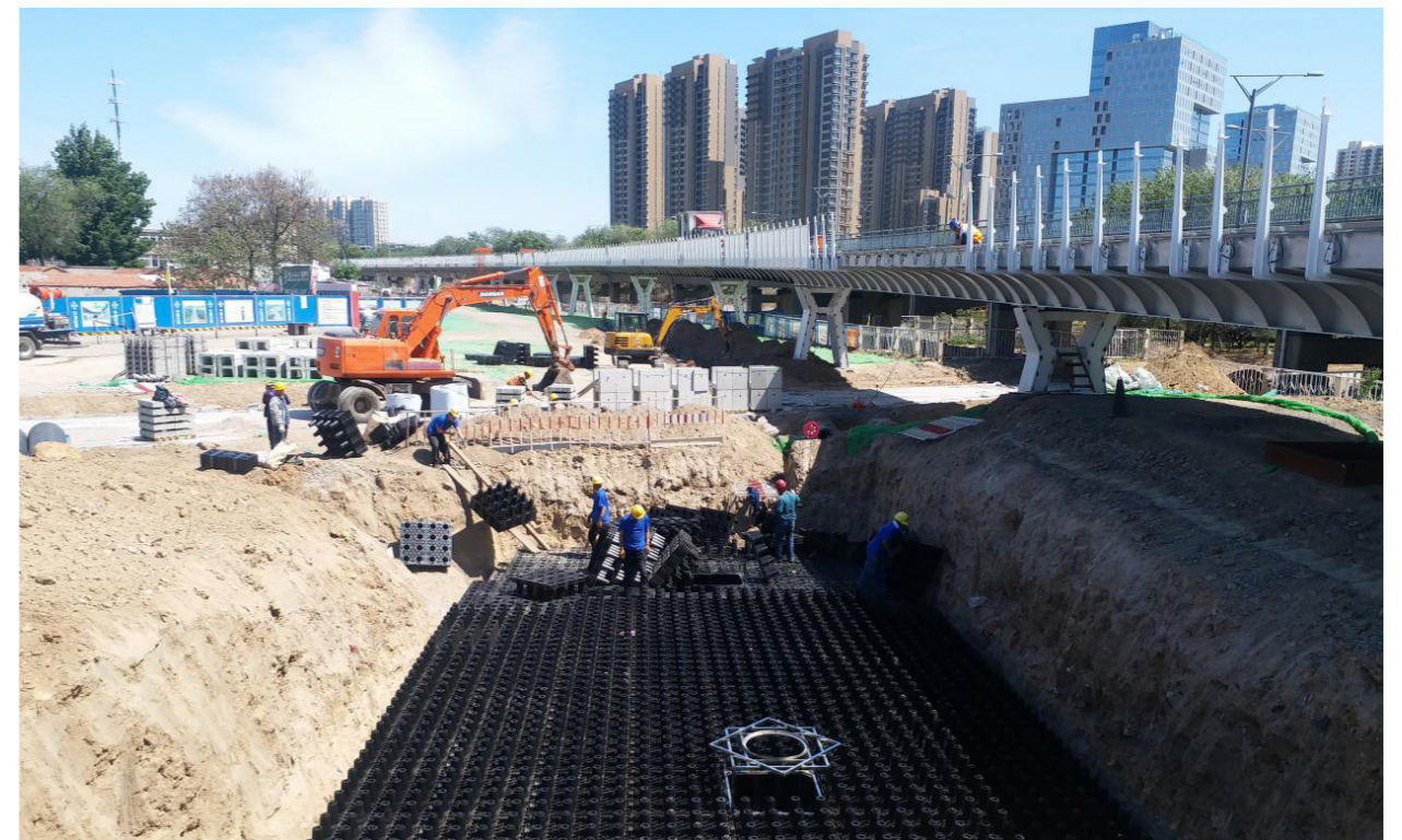
采用分体式 PP 塑料模块建设蓄水池，模块可循环利用
