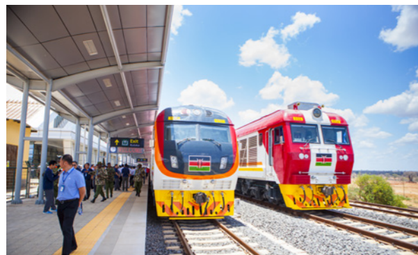
新建肯尼亚蒙巴萨至内罗毕标轨铁路工程
