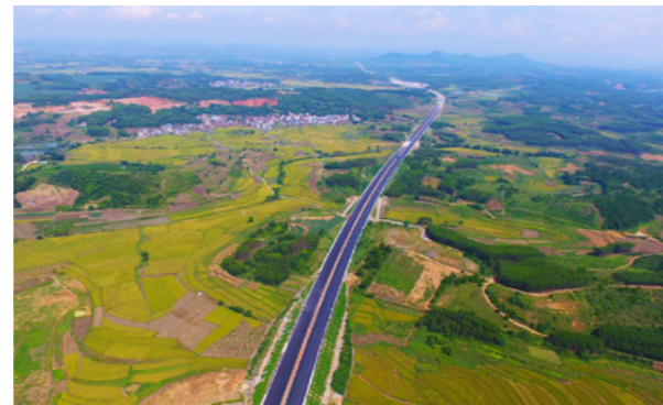
广西河池至都安高速公路工程
