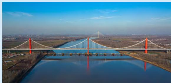
济南黄河凤凰大桥——全长3,788米，为三塔自锚式悬索桥，桥面整幅宽61.7米，是最宽的跨黄河大桥
