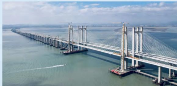
福厦高铁泉州湾跨海大桥——全长约20公里，海上桥梁长8.96公里，主桥长800米、主跨400米，为双塔双索面钢混结合梁半漂浮体系斜拉桥
