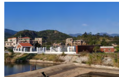
农村分散式污水处理站
