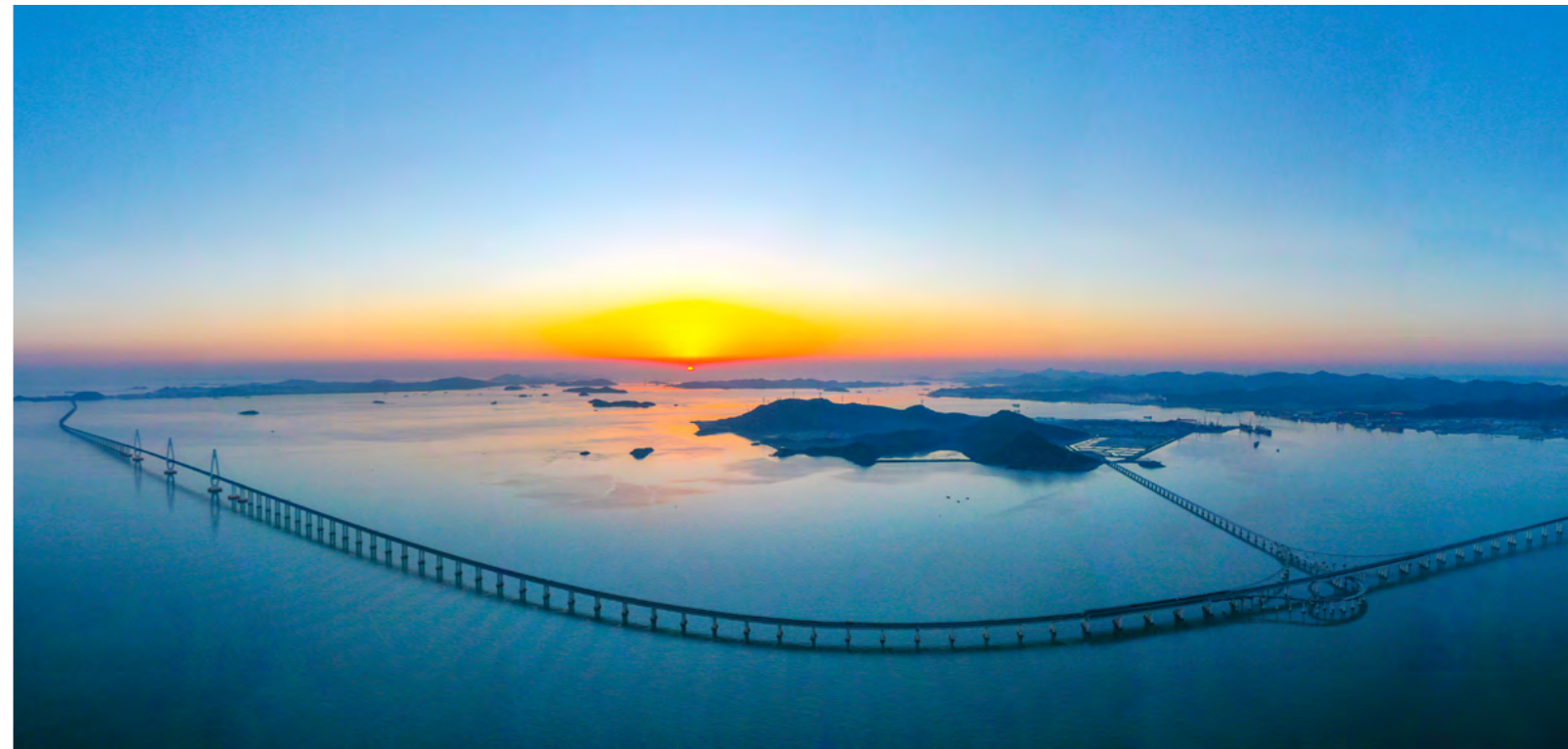
宁波舟山港主通道项目全线建成通车
