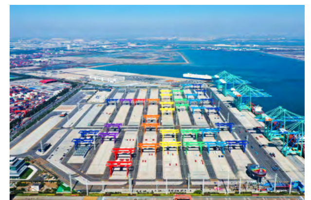
全球首个“智慧零碳”码头——天津北疆港区 C 段智能化集装箱码头
