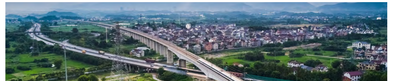
杭黄高铁东起“人间天堂”杭州，西至“天下第一奇山”黄山，项目部将“美丽杭黄、生态高铁”的理念深度融入建设过程，最大限度对施工占用土地进行复垦和复绿，确保线路实现“四季常绿、三季有花、乔灌结合”
