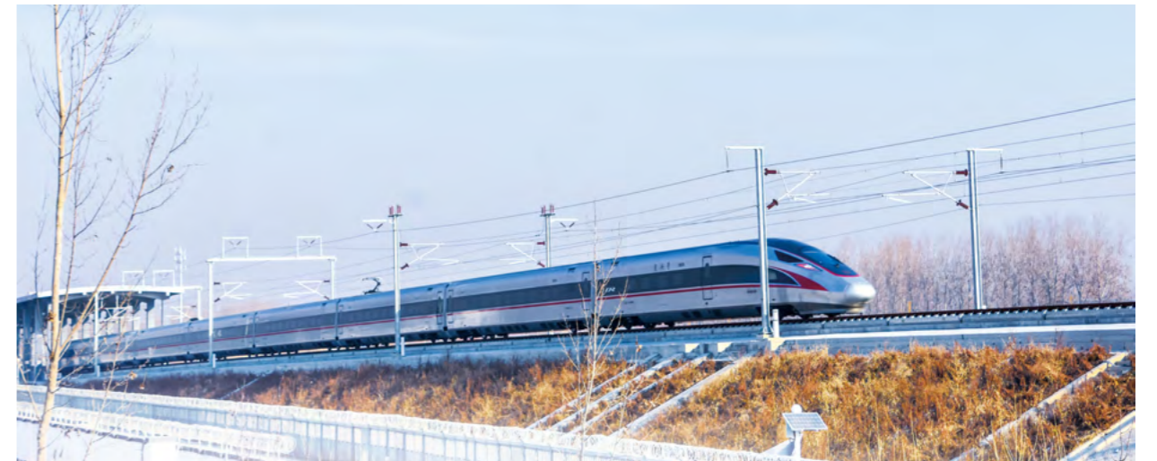
京雄城际铁路
