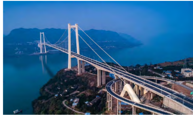
重庆万州至湖北利川高速公路（重庆段）驸马长江大桥
