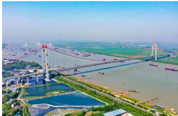
湖南省临湘至岳阳高速公路洞庭湖大桥
