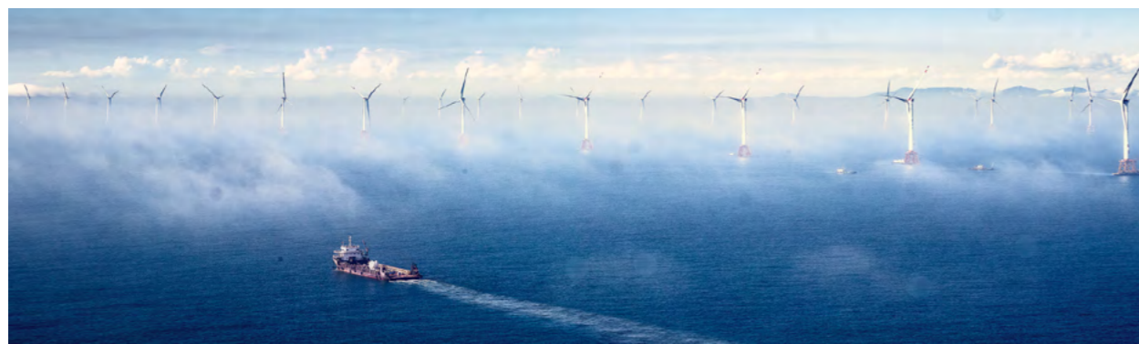
三峡阳西沙扒海上风电项目
