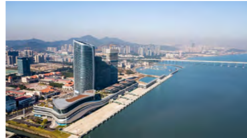
广州南沙国际邮轮码头作为全国规模最大的邮轮母港综合体的重要组成部分，顺利通过竣工验收
