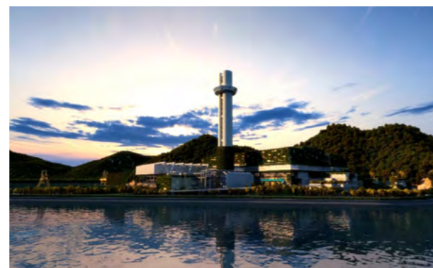
香港综合废物处理项目
