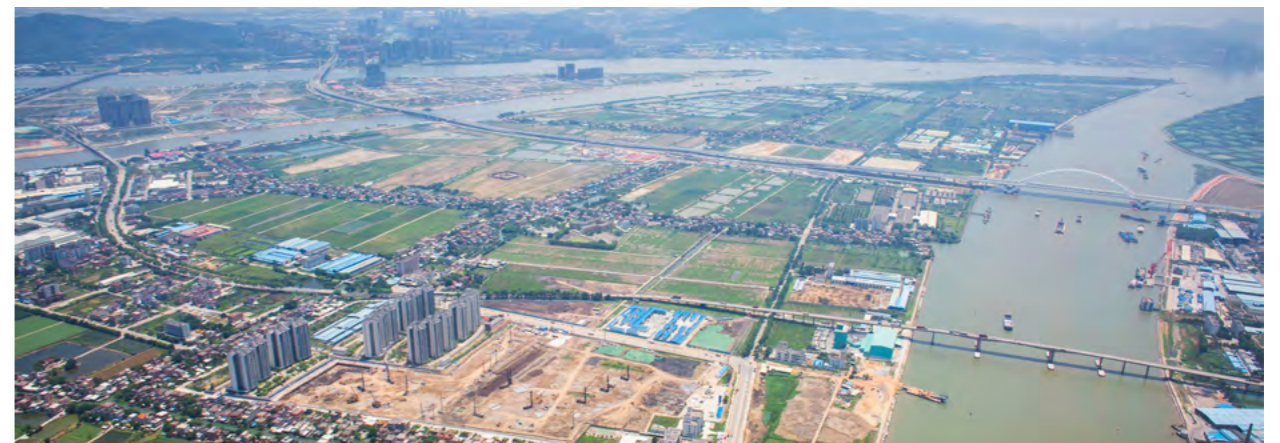
南沙灵山岛尖横沥项目实景图
