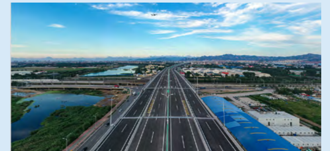
8月12日，青岛胶东国际机场正式投运。该机场被列为中国民航首批18个“智慧型机场”示范项目之一
