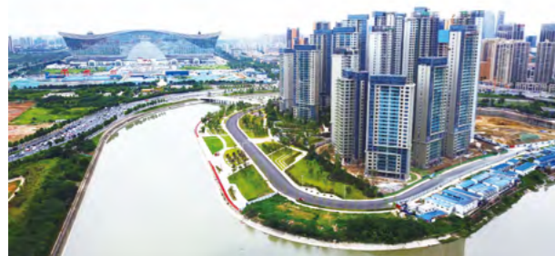
四川锦江流域水环境治理项目
