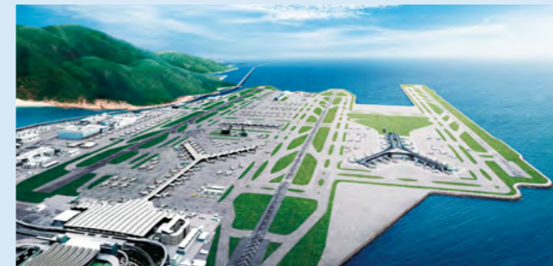
9月7日，香港国际机场第三跑道填海工程跑道铺设工程竣工。该工程投入使用后将极大提升香港国际机场的运量，巩固香港国际航空交通枢纽地位，加快推动香港经济社会发展
