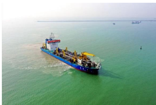
山东日照港岚山港区深水航道二期
