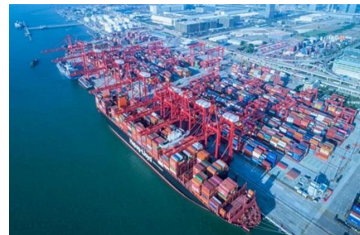
5G智慧港口-妈湾智慧港正式开港
