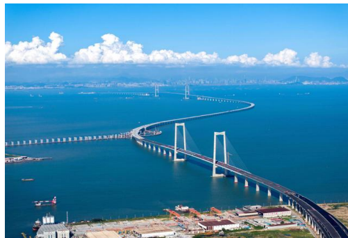
深中通道海底隧道
