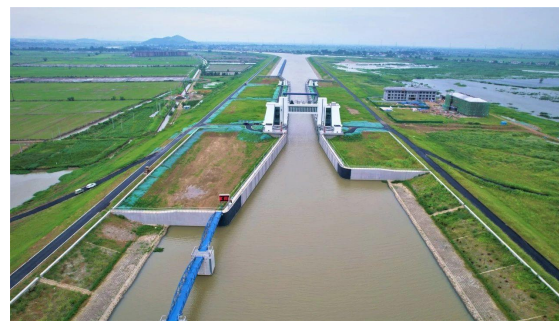
安徽引江济淮一期工程
