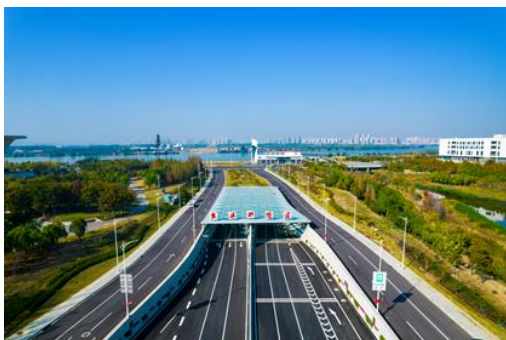
湖北襄阳市襄江大道鱼梁洲隧道
