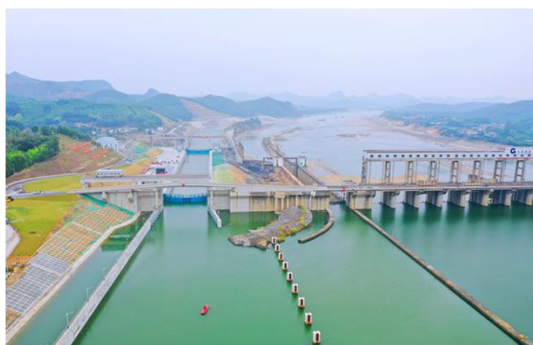
广西柳江红花水利枢纽二线船闸工程
