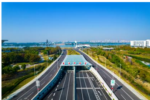
湖北襄阳市襄江大道鱼梁洲隧道
